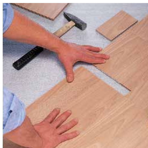
Posizionamento della doga in laminato, maschio, femmina
